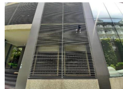
ท่อระบายอากาศห้อง Generator
