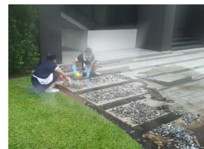
การทำความสะอาดวางระบายน้ำรอบโครงการ
